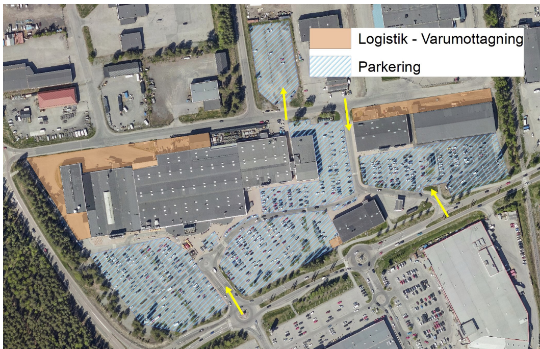
Bild 7: Bilparkeringar och logistikytor, fastigheten Storheden 1:37. Gula pilar visar fastighetens infarter.
