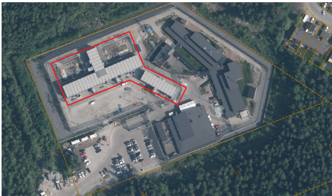
Bild 2: Bilden visar den befintliga strukturen och bebyggelsen inom fastigheten Porsön 1:401. Byggnader markerat i rött har tidsbegränsade bygglov då de bedöms planstridiga mot gällande detaljplan A317 (1974)
