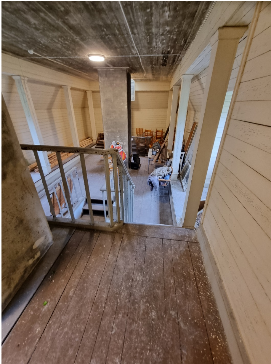
Vindsvåningen sedd från den högre etagen. Rummet är disponerat för museiutställningar. Längs sidorna är golvnivån högre och utrymmet är genom pelare indelat i sektioner. Foto 2025.
