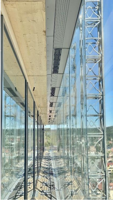
Figur 4: exempel på yttre glasfasad.
