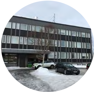
Fasadmaterialet har bytts med följden att fasaden har förvanskats.
