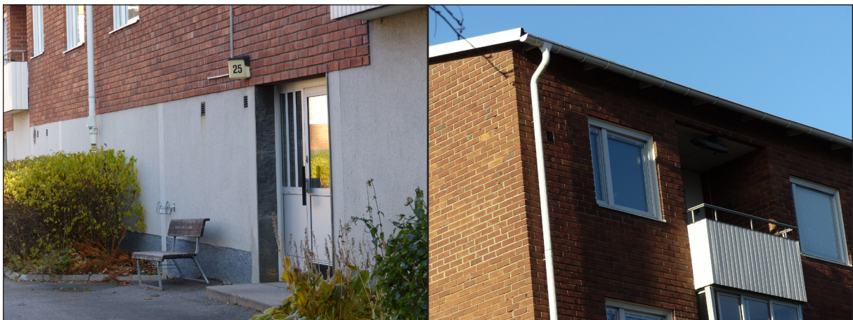
Ursprungliga fasadmaterier och detaljer men utbytta entrédörrar och balkongfronter.
