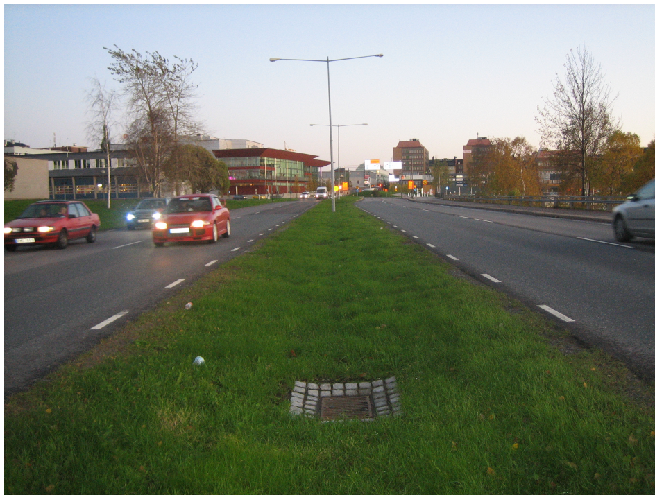
Figur 10. Dike i direkt anslutning till väg
