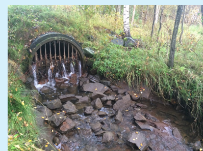
Figur 14. Utlopp delvis igensatt
