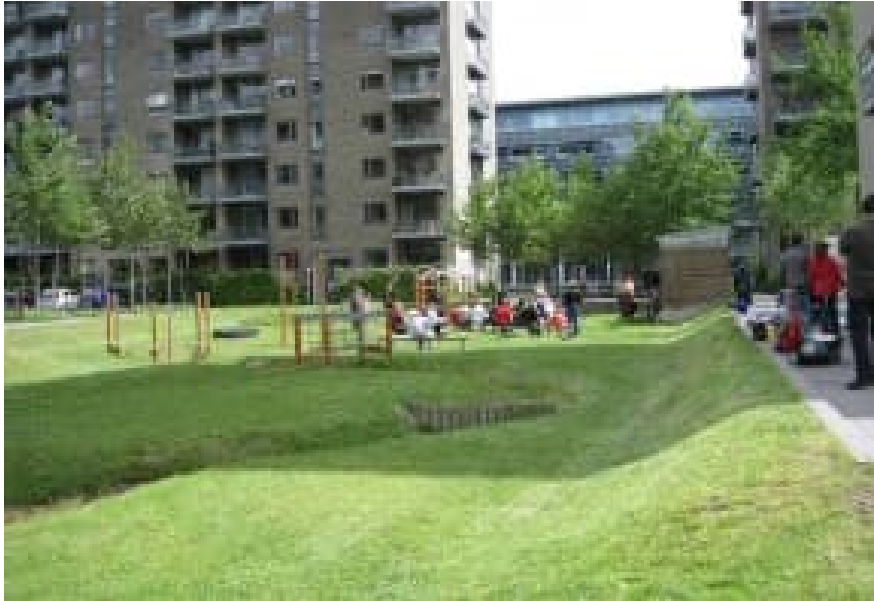
Figur 22. Torr fördröjningsdamm med lekplats i Ørestad (mångfunktionell yta), DK. Foto: Christian Nyerup Nielsen
