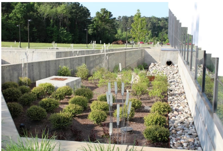
Figur 18. Dagvattenbiofilter. Foto: Laila C. Søberg
