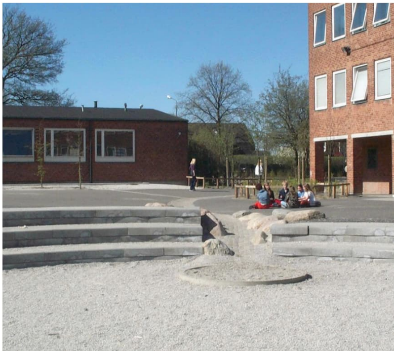
Figur 21. Torrdamm vid en skola i Malmö. Foto: Joakim Pramsten, Stockholm Vatten och Avfall.
