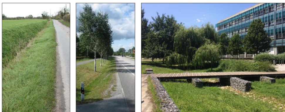
Figur 16. Väg- och svackdike med olika släntlutningar. Foto: Svenskt Vatten, 2019
