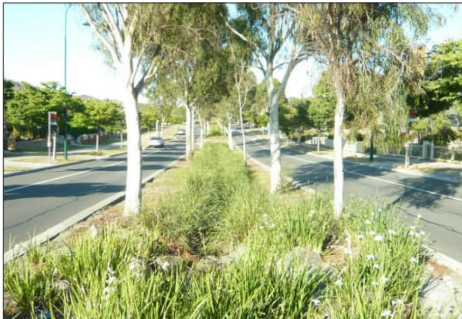
Figur 20. Biofilter i dike med dräneringsrör. Foto: Svenskt Vatten, 2019
