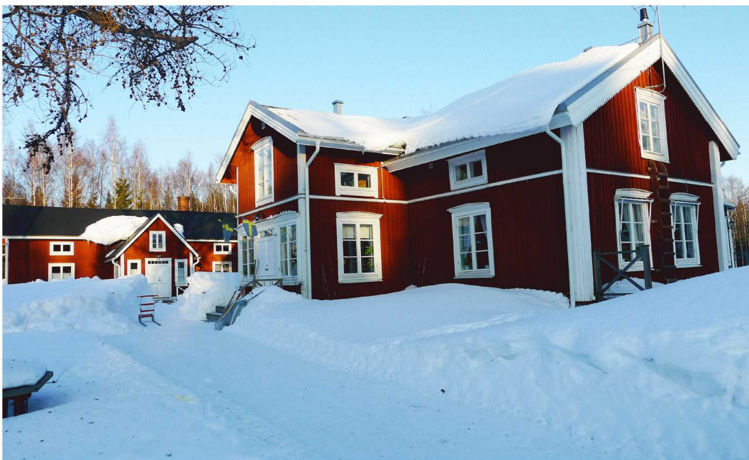
Ovan till vänster: Dränglängan. Ovan höger: Bagarstugan. Nedan: Mangårdsbyggnaden
