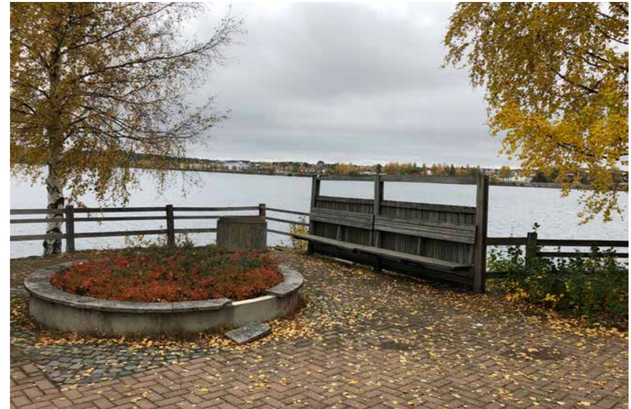
Befintlig grillplats är i slitet skick.
