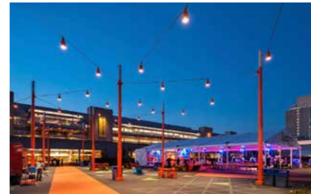
Linspänd belysning vid entréer
