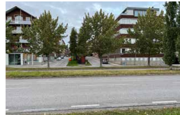
Trafikleden längs Södra Hamnpromenaden är dominerande
