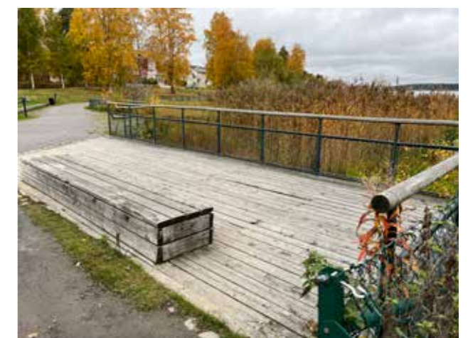
Befintligt trädäck med staket.
